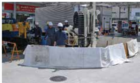
SS営業中浄化工事（参考写真）
